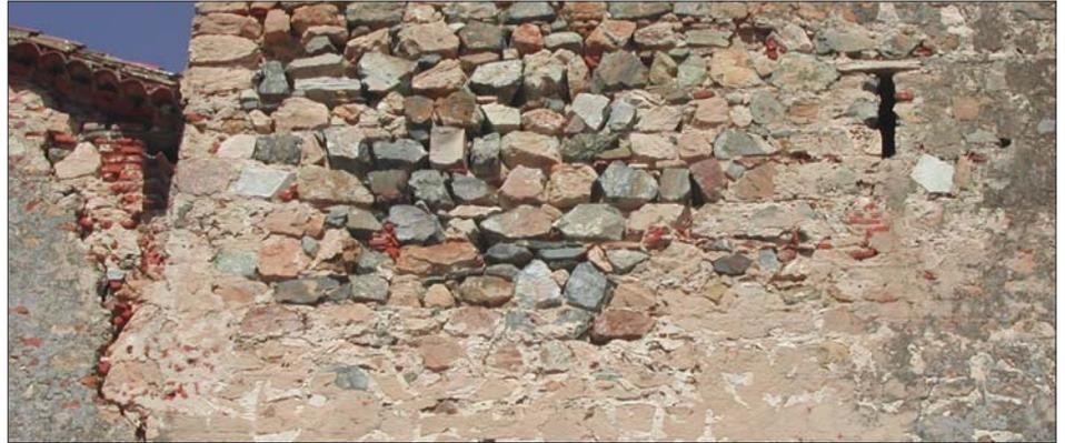
Westfassade, Anschluß des Turms mit lageweise gesetztem Feldstein-Mauerwerk an den in Backstein ausgeführten westlichen Abschluß des Langhauses (Foto Gussone 2003)
